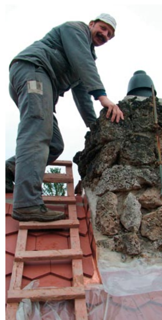
Zerklüfteter Tuffstein war im Rokoko hochmodern, entsprechend schwierig gestalten sich die Abdichtungsarbeiten mit Kupferblechen.
