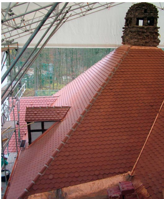
Vermörtelte Gratziegel verlangt der Denkmalschutz, groß dimensionierte Dachgräben sichern gegen Eisstau.
