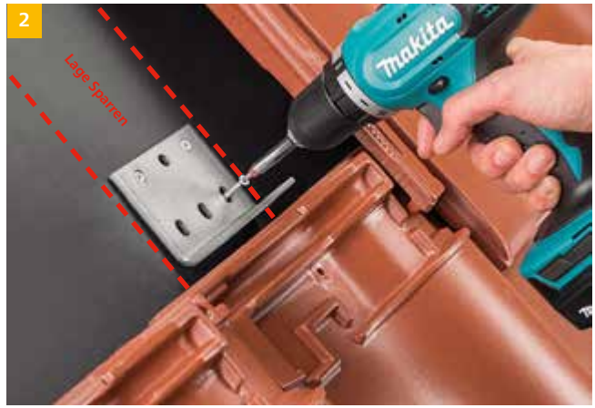
Sparrenaufgabe mit mind. 2 Stück 8er Vollgewindeschrauben (nicht im Lieferumfang enthalten) auf der Holzkonstruktion fixieren. Durch die verschiedenen Lochreihen kann die Solarmodulstütze beidseitig jeweils um bis zu 60 mm verschoben werden.
