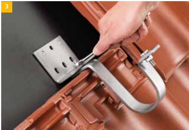
Haken der Solarmodulstütze auf Höhe der Kopfverfaltung druckfrei fixieren.
