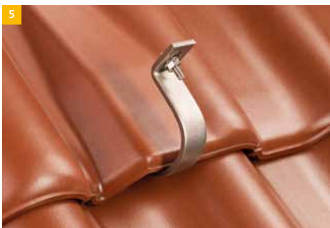
Lüftungsziegel aufdecken. Trägerschienen mit der Solarmodulstütze verschrauben.
