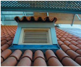
Exakt in das Deckungsbild eingepasste Gaube
