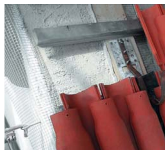
Auskragende Edelstahlunterkonstruktion
