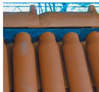
Firstanschlussdetail mit vorpatiniertem Kupferblech
