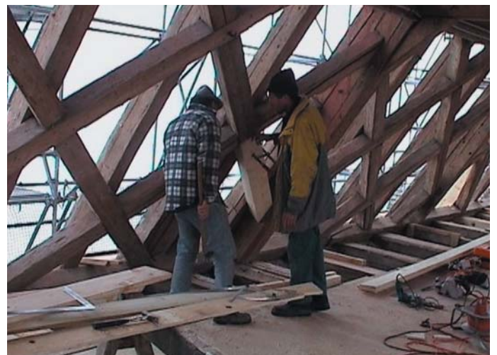
Zimmererarbeiten am gotischen Dachstuhl
