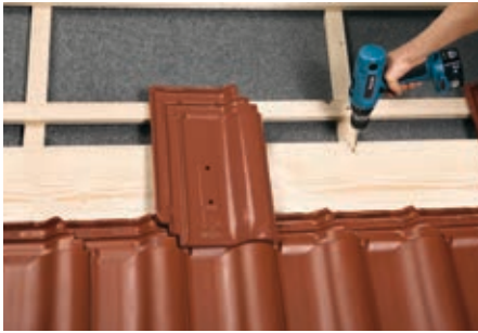
1. Holzbohle, S10 (in Lattenstärke, jedoch mind. 40 mm Dicke und 150 mm Breite) zur Aufnahme der Halterungsschraube (mit 3 Stück 6 mm Spax/Vollgewinde) auf den Sparren anschrauben. Die Schrauben müssen mind. 6 cm in den Sparren eindringen (Konterlattenhöhe bzw. evtl. Schalung beachten).
