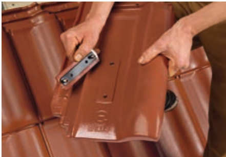
3. Die 2-teilige Solarhalterung trennen und das untere Teil auf der Alu-Grundplatte befestigen.
