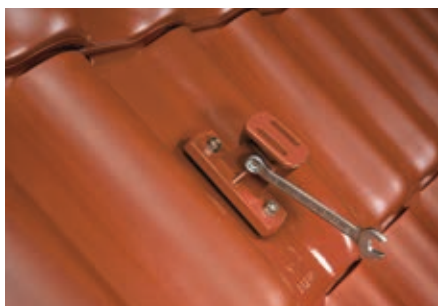
10. Einstellung der Aufstandsfläche der oberen Halterung parallel zum Sparren (Voreinstellung von 4° bei profilierten Dachziegeln, bzw. 8° bei Biber möglich).
