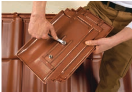
4. Schrauben an der Unterseite anziehen.
