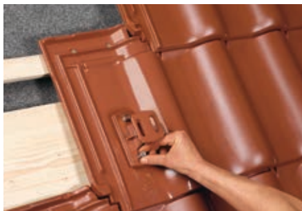
8. Obere Solarhalterung aufbringen.
