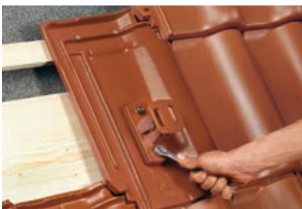
9. Mit Schraubenschlüssel (13 mm) aufschrauben.
