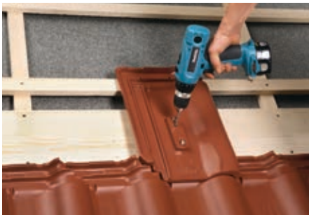
5. Bohren der Löcher durch die Alu-Grundplatte (Bohrer 6 mm) zur Befestigung in die Bohle.
