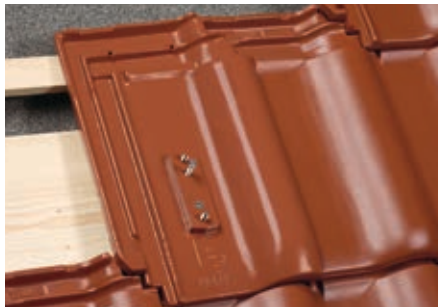
6. Lockere Befestigung mit Schrauben (6 x 80 mm).
