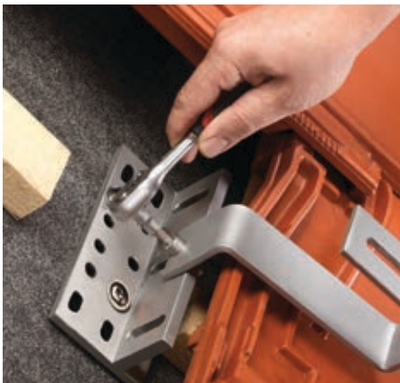
3. Oberteil der Solarmodulstütze auf Höhe der Kopfverfaltung druckfrei fixieren.
