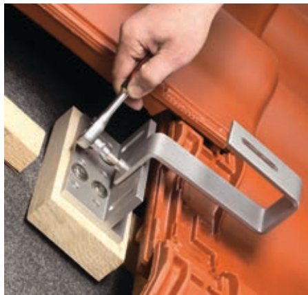
3. Oberteil der Solarmodulstütze auf Höhe der Kopfverfaltung druckfrei fixieren.
