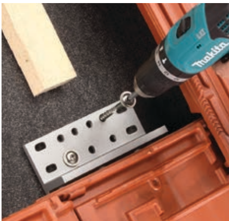
2. Solarhalterschiene in Konterlatten- oder Sparrenebene mit mind. zwei Schrauben (mitgeliefert) fixieren. Die Riffelungen an Schiene und Winkel ermöglichen eine genaue Justierung und verhindern ein Verrutschen der Konstruktion.
